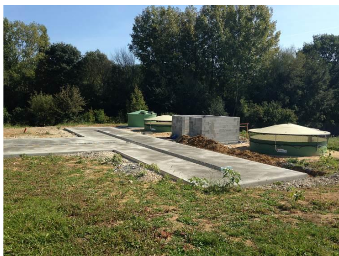
Photo 1 : Aire collective de lavage des pulvérisateurs et de traitement des effluents phytosanitaires (Guéreins, travaux en cours) Source : SRTC
